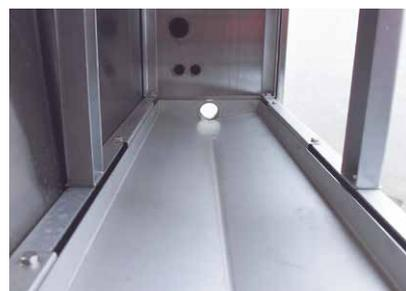
結露水、逆流防止器からの排水をドレンパンで受けます。ドレンパンには勾配を設けていますのでキャビネットの外へ自然流下で排水されます。
